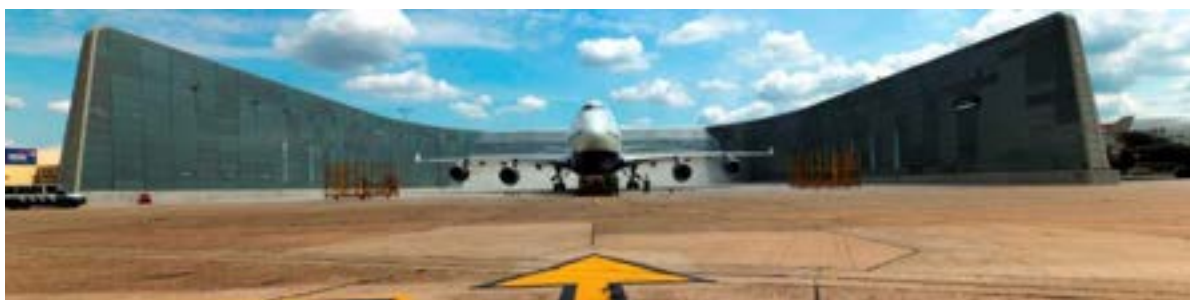
Figure 14 : Murs anti-bruit pour la réalisation des essais moteurs au sol, sur l'aéroport d'Heathrow Source : (jac acoustics, 2013)
