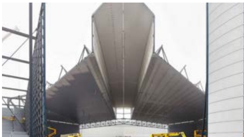
Figure 15 : Hangar isolé acoustiquement pour la réalisation des essais moteurs au sol sur l'aéroport de Zurich Source : (Zurich airport, 2025)
